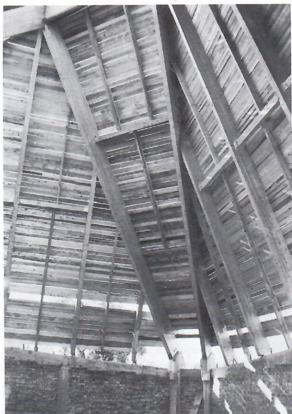
A tetőszerkezet „alulnézetből”
