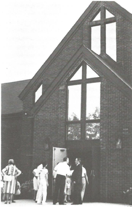
Az buffaloi imaház homlokzati képe.
