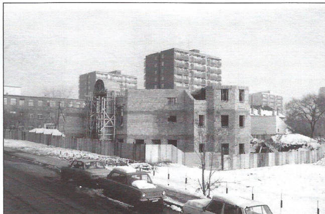
Az épülő imaház
