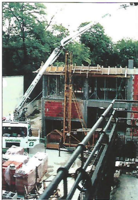
16. Készül a betonfödém
