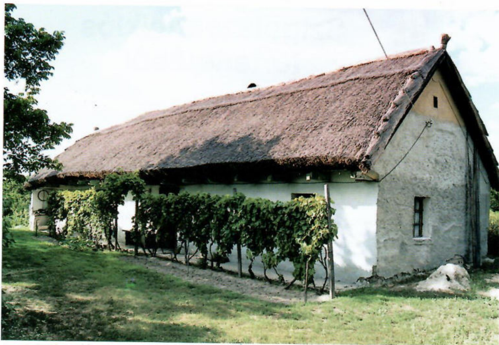
Török Ferenc „fecskerakásos” módszerrel készült nádfedeles háza a Kinizsi utcában
