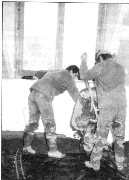
Február 25-re a felső két szint fűtőszelése és aljzatbetonozása is elkészült
