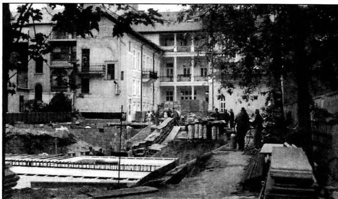
A missziós központ építése megkezdődött (április)
